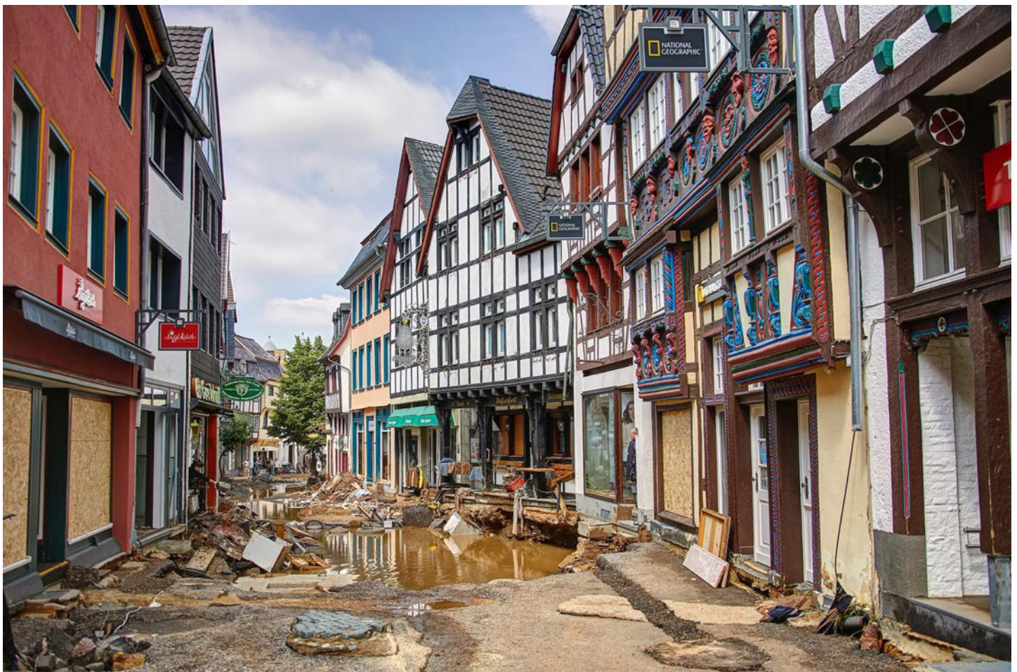
NW Bad Münstereifel, Germany: flooding "Hochwasser" 2021. © Roland Rossner / DSD
